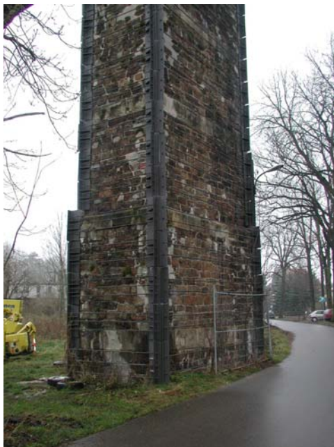
Fig. 10: Geschädigter, schiefgestellter Pfeiler
